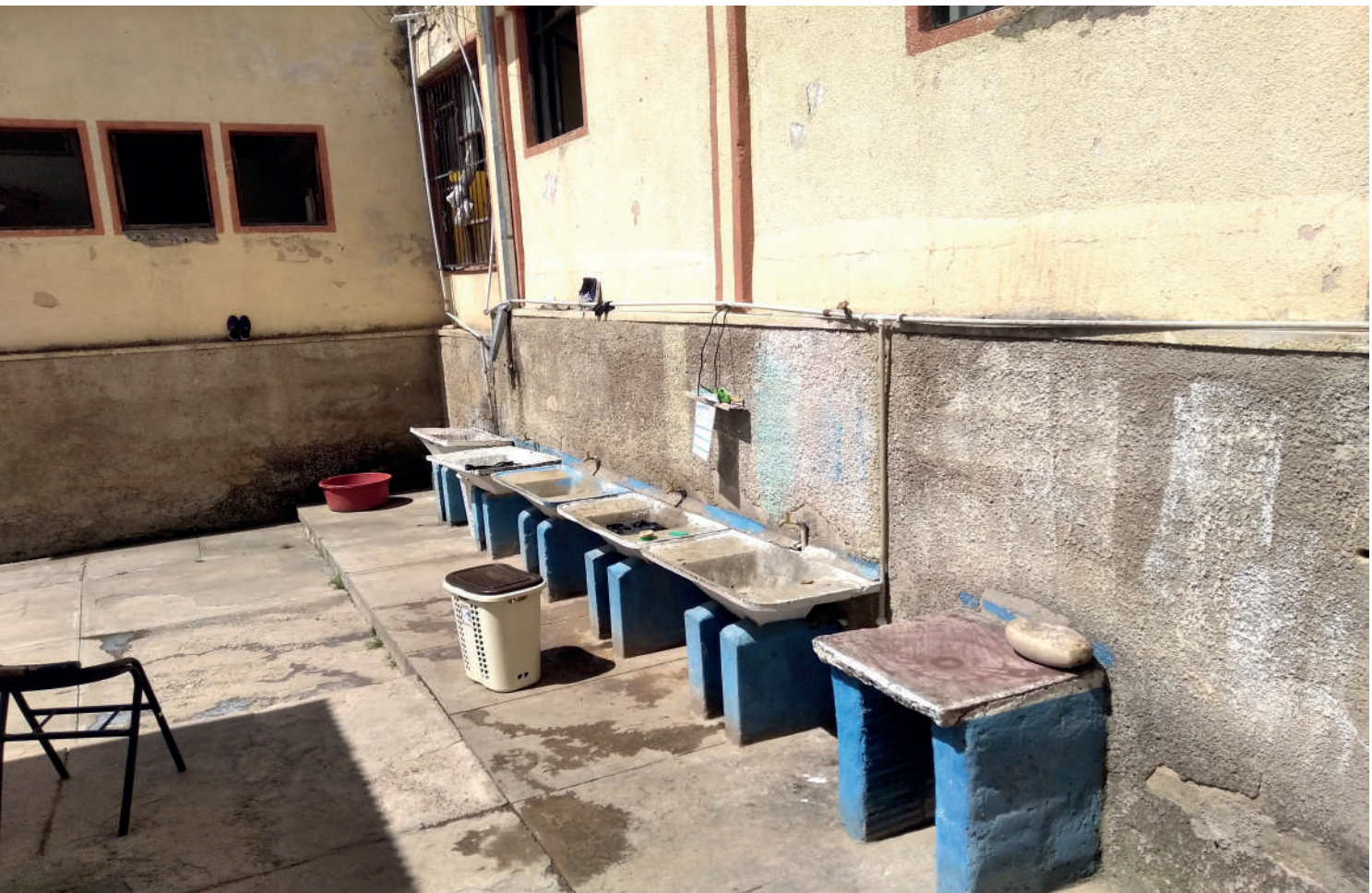
Infraestructura - CRS Chuquisaca
